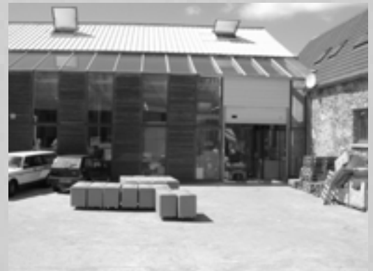
Versandlager der Firma L-Acoustics
